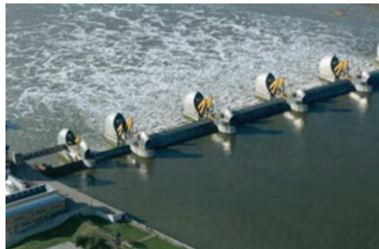
〈그림2〉 영국 런던 템즈강 홍수방어벽(Thames Barrier)
